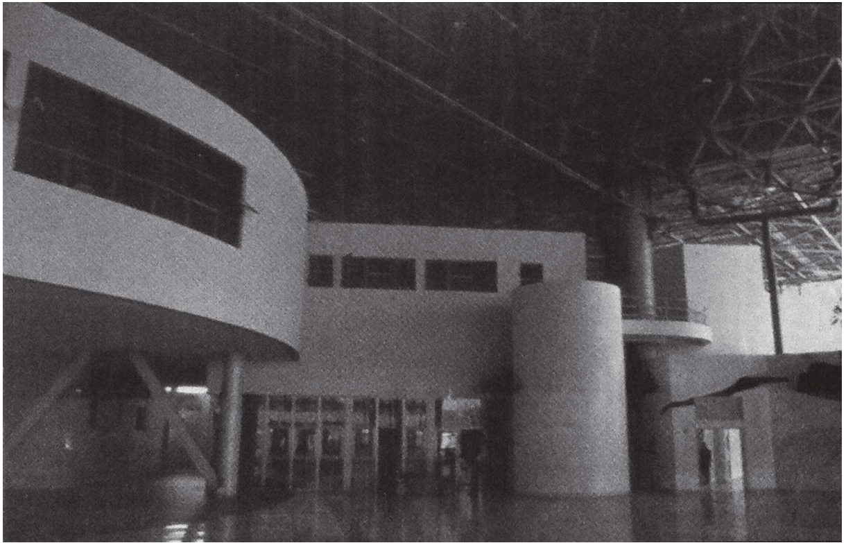
Interior del edificio. En primer plano el cilindro donde se diseñaron las instalaciones gastronómicas de servicio al público.
