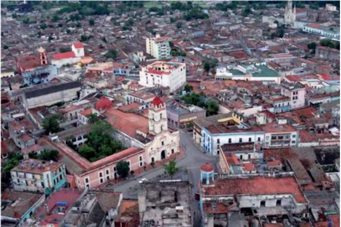
Camagüey, Plaza de los Trabajadores e Iglesia de La Merced. Foto: Ernesto Guzmán Lastre.
