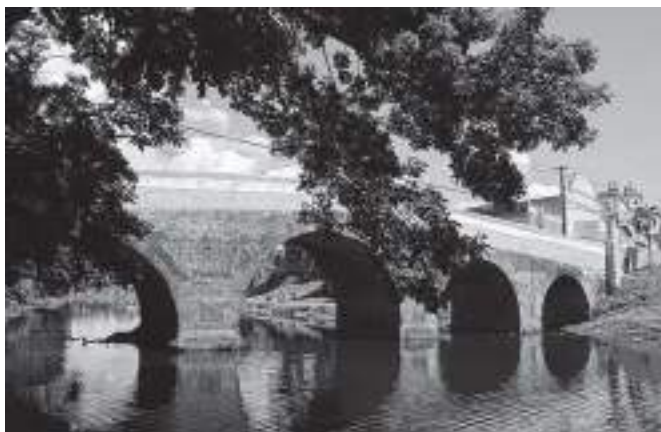
Puente sobre el río Yayabo, Sancti Spíritus. Foto: Julio Larramendi Joa.
