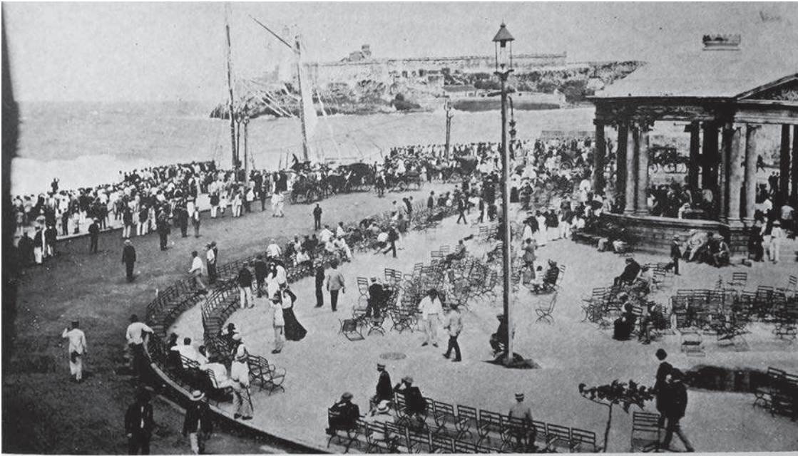
S EFECTOS DEL CICLÓN.—VISTA DEL MALECÓN Y LA GOLETA "ELVIRA," DE LA MATRÍCULA DE SAGUA, LANZADA POR L CONTRA EL MURO FRENTE Á LA GLORIETA.
